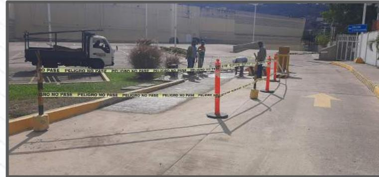
**Trabajo :** Aprovechando la demolición del concreto se recuperó la acometida eléctrica y de comunicación de la máquina entrada derecha de puerta 1.
