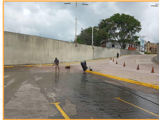
Lavado de Puestos de estacionamiento, Aceras y Brocales
